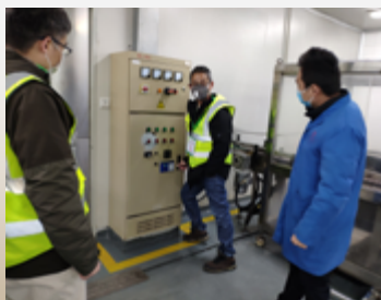
复工前安全专项检查
